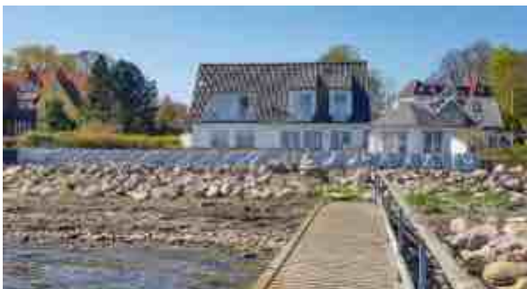
Ansicht von der Ostsee auf die aufgebaute AquaWand.
